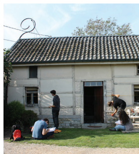
Maison sise à Barvaux-Condroz, rue Sommelette n° 10. Pignon nord et gouttereau ouest de l'annexe en pans-de-bois © L. Hardenne.
