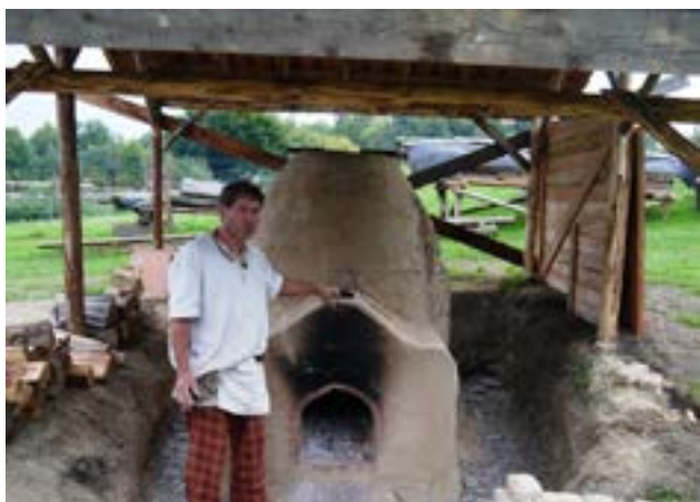
Chantier-four de potier © Malagne La Gallo-romaine
